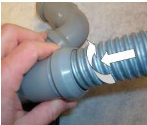
Ziehen Sie den alten Abwasserschlauch von der Maschine ab
