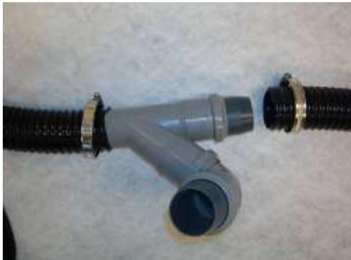
Ziehen Sie den alten Abwasserschlauch von der Maschine ab.
