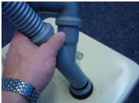
Kürzen Sie den Abwasserschlauch so, dass das Abzweigstück einerseits ausreichend tief und fest im Wasserkasteneinsatz sitzt, sich aber auf der anderen Seite für die Reinigung des Wasserkastens gut entfernen lässt
